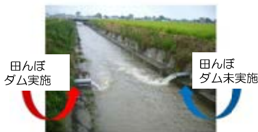
排水状況の比較 平成23年7月新潟・福島豪雨 白根郷地区(新潟市)
