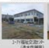
1-71福祉交流センター(造水性舗装)
