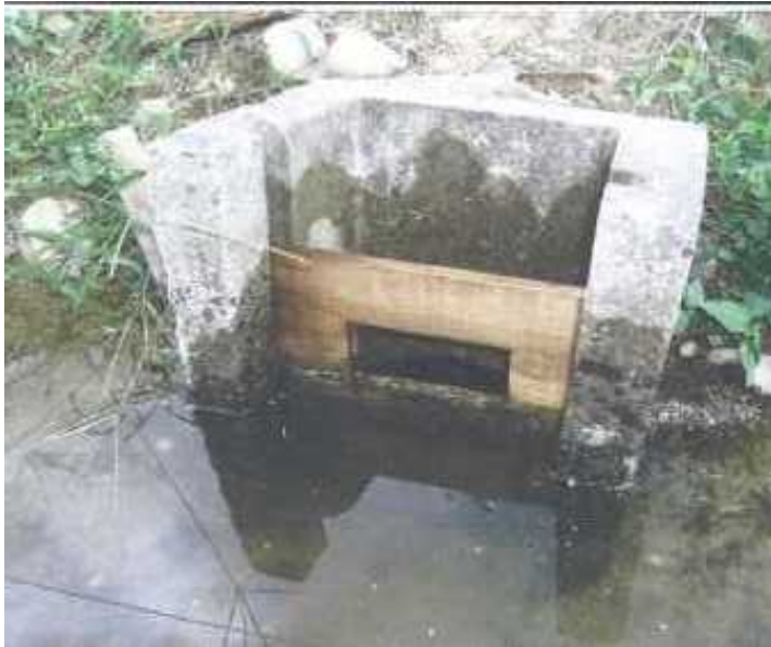
落水口に設置したせき板
