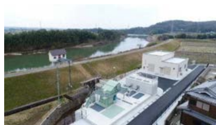
河高地区安取雨水ポンプ場全景
