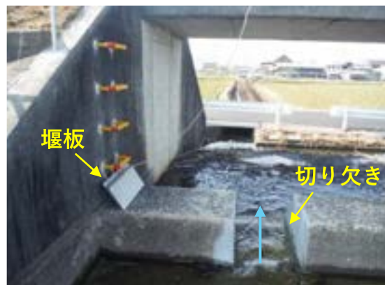
開発行為により設置した調整池
