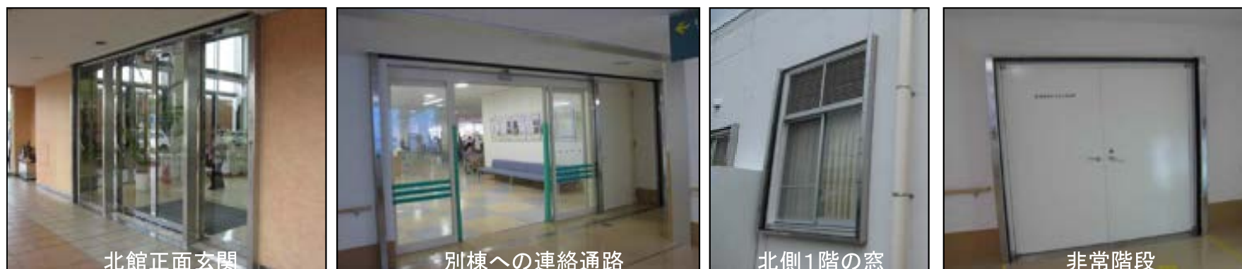
止水板のための角落しとの設置
