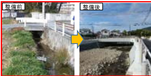
橋梁改築(山根川)(兵庫県)
