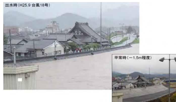
平成25年台風18号のときの福知山市街付近の堤防の様子 家の2階に相当する高さまで水位が上昇し、堤防が決壊寸前。
