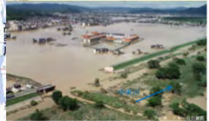
左岸3k400破堤状況
