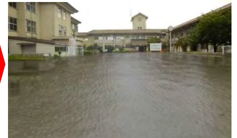
〇〇小学校 浸水後 (1.2m)
