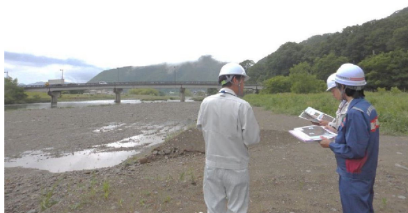
宍粟市 工作物(橋梁)・洗堀・越水
