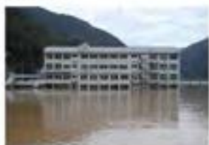
H26.8避難所2階の浸水(徳島県)
