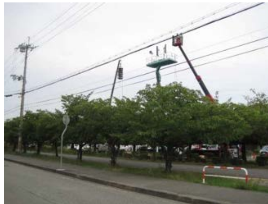
同報系防災行政無線デジタル化整備事業 音響伝達調査のようす（高砂市）
