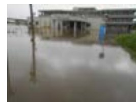
浸水時の状況 (喜多方市提供)
