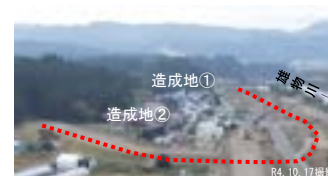
移転家屋の建設が進む状況
