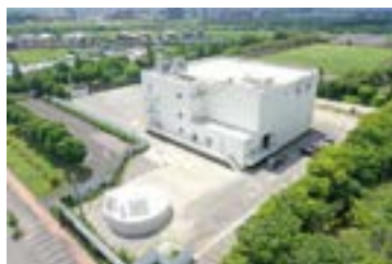
雨水ポンプ場
