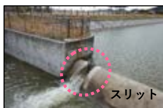
▲スリットの設置状況
