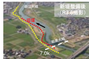
引堤(石川県梯川水系梯川)
