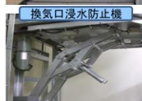
地下への浸水防止対策
