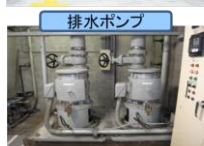
地下への浸水防止対策
