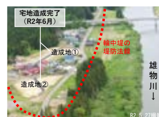
移転先宅地造成完了状況
