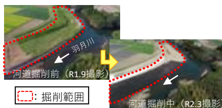
河道掘削(鹿児島県内川水系羽月川)
