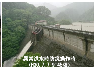
平成30年7月豪雨時の 引原ダム放流状況
