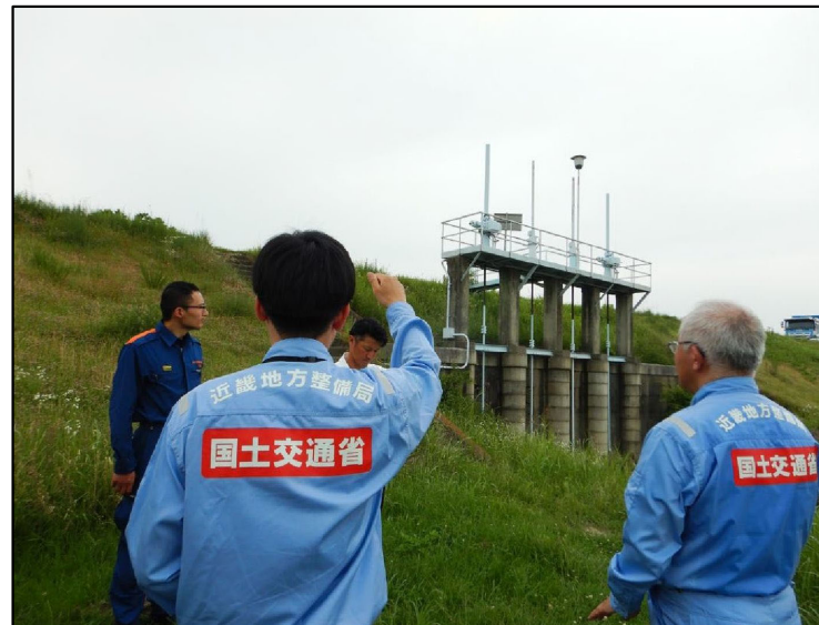
重要水防箇所の共同点検の様子 令和6年6月20日
