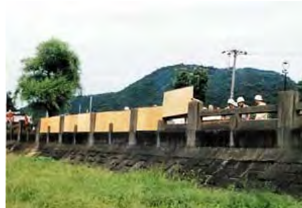
普段は橋の欄干風。堤防と気づかない人も多い。しかし畳をはめ込んだら氾濫を防ぐ堤防に変身。
