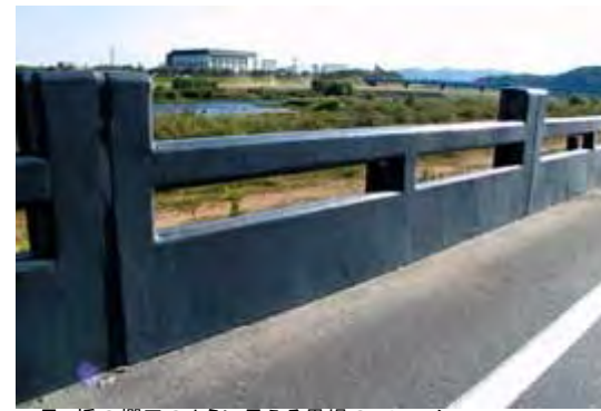
一見、橋の欄干のように見える量堤のフレーム
