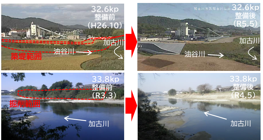
■加古川中流部緊急治水対策(H29～実施中)
