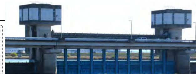
予備ゲートを設置した 3 号ゲート
