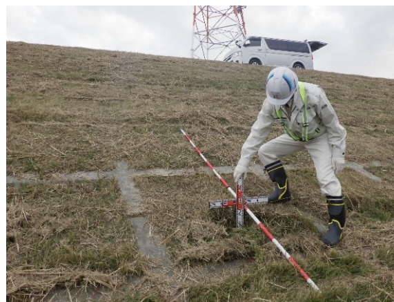
▲堤防点検の様子
