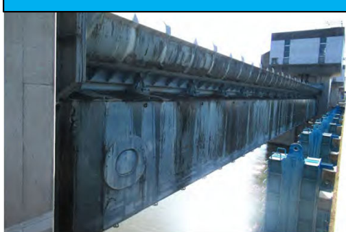
修繕工事で引き上げた 3 号ゲート扉体
