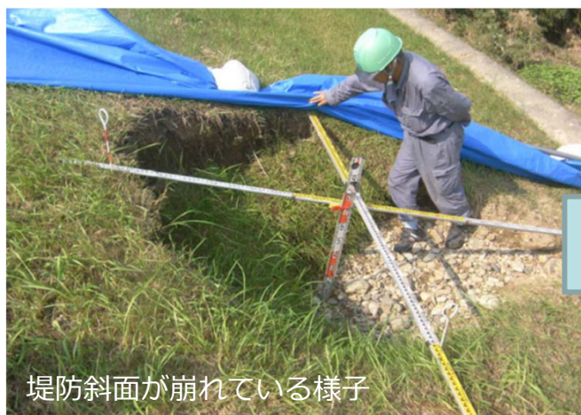
崩れた堤防斜面への応急対応の様子（平成30年7月の例） 加古川右岸27.0k付近
