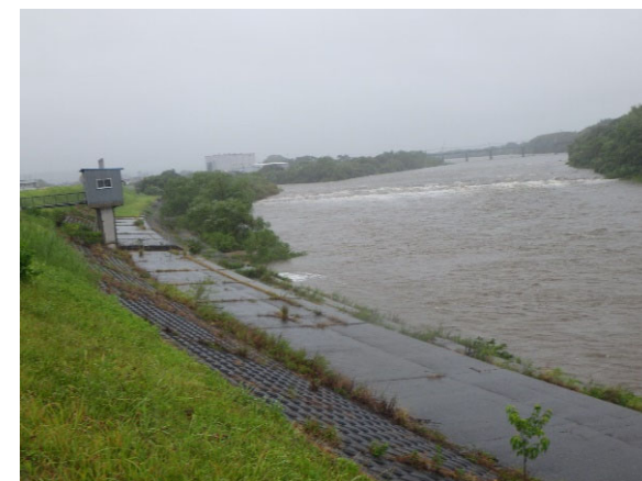
土のうを設置
