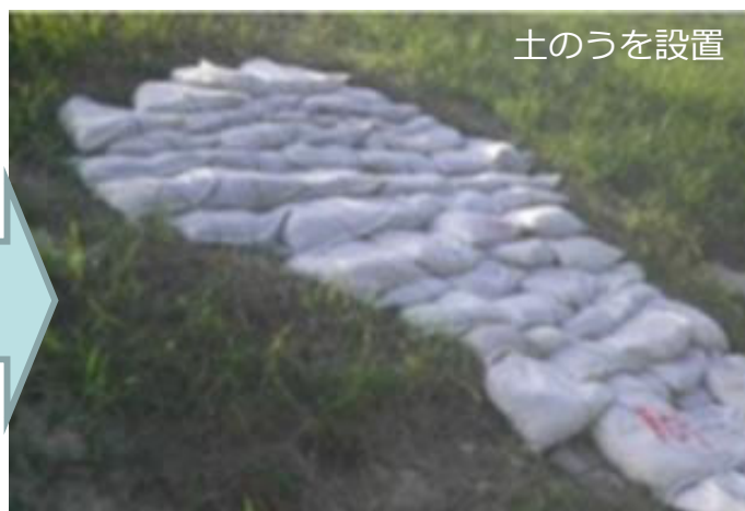
崩れた堤防斜面への応急対応の様子（平成30年7月の例） 加古川右岸27.0k付近
