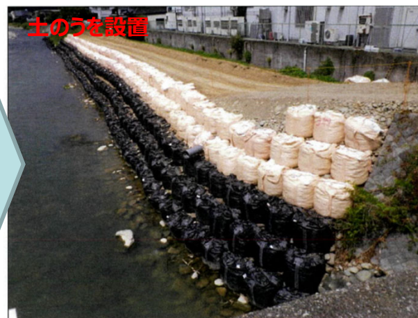
▲崩れた堤防斜面への応急対応の様子（平成30年7月の例） （閤賀地区）揖保川左岸44.2k付近
