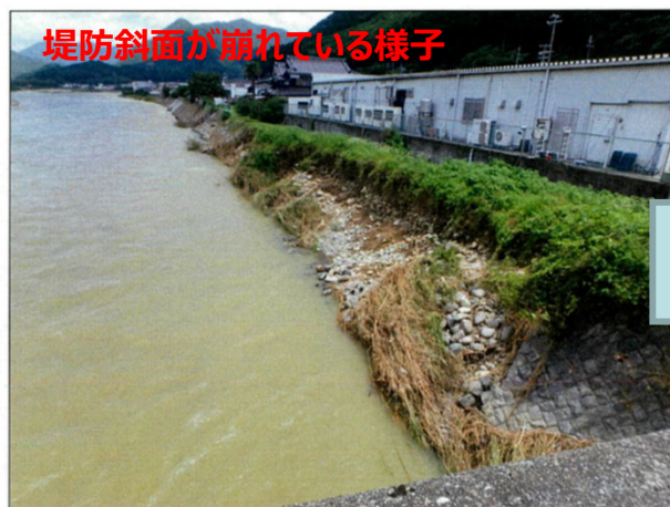
▲崩れた堤防斜面への応急対応の様子（平成30年7月の例） （閤賀地区）揖保川左岸44.2k付近
