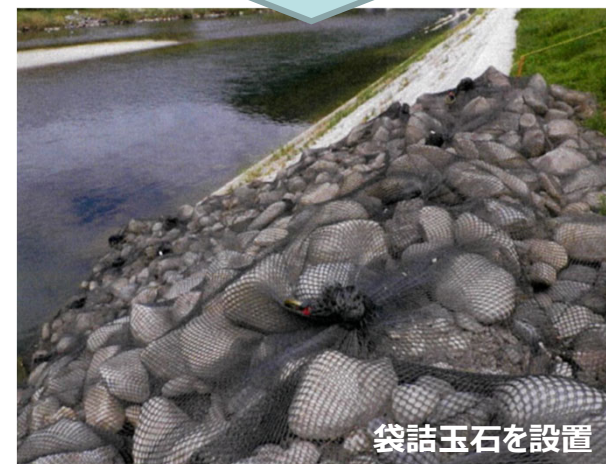
▲崩れた護岸への応急対応の様子 （平成30年7月の例）
