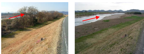
図 1.5.10 礫河原（23.6km 付近）
