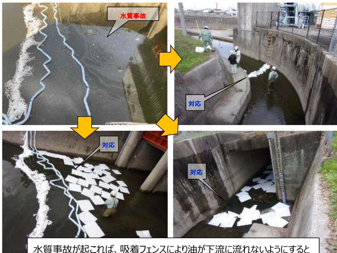
水質事故が起これば、吸着フェンスにより油が下流に流れないようにするとともに、残った油を吸着マットに吸着させます。
