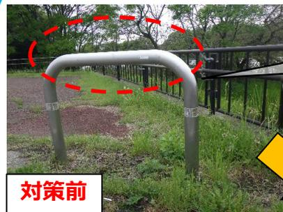
河川へ降りる道の入り口に設置されている車止めの反射テープが劣化していることを確認
