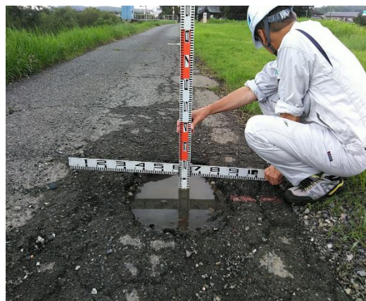
▲堤防点検の様子
