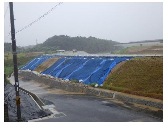
降雨時の巡視状況（令和5年）
