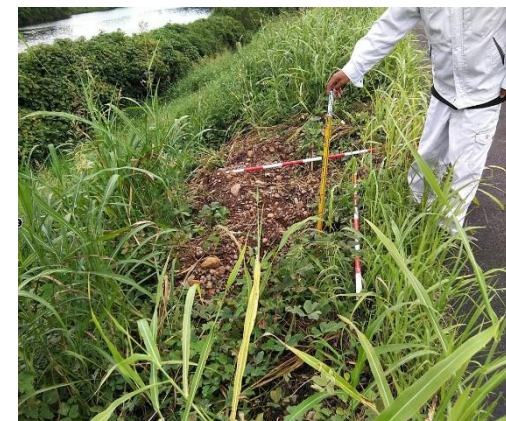
▲河川管理施設の状況確認
