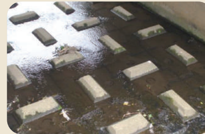
床止工(護床工)
