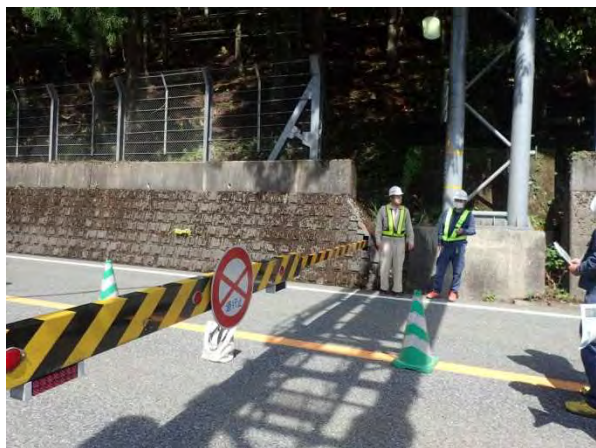
▲通行止め実施の様子 (通行規制状況)
