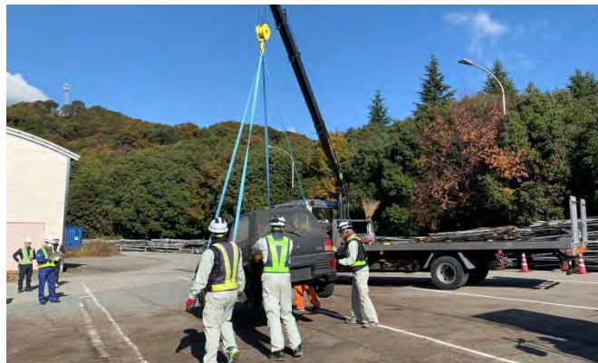
▲ クレーン車両による放置車両の移動
