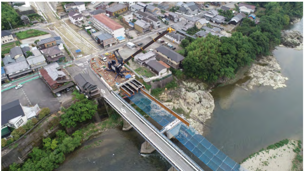
滝見橋工事状況
