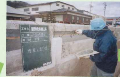
3.モルタルやパテ材を塗って、表面の凸凹を滑らかに
