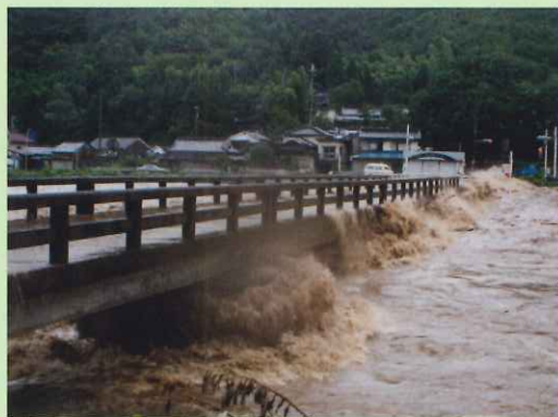
兵庫県宍粟市山崎町 旧神河橋付近
