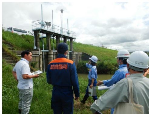
昨年度点検の様子(加古川市洗川樋門)
