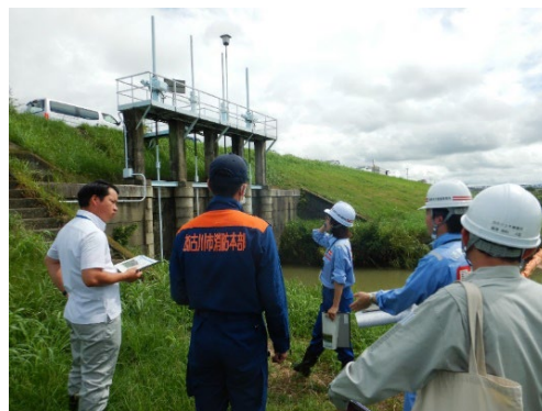
昨年度点検の様子(加古川市洗川樋門)
