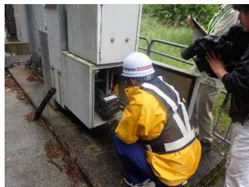
▲ 手動でも遮断機を下ろすことは出来ます。 万が一に備え手動での操作も実施しました。
