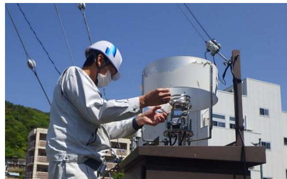
雨量計 点検の様子
