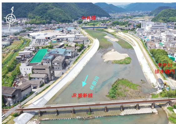
整備後(JR姫新線上流)
