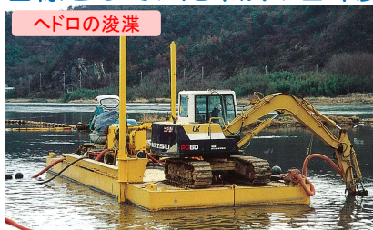
ヘドロの浚渫
