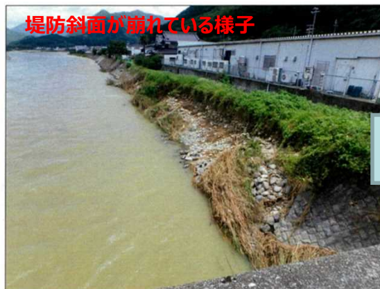
崩れた堤防斜面への応急対応の様子 (関賀地区) 揖保川左岸44.2k付近
