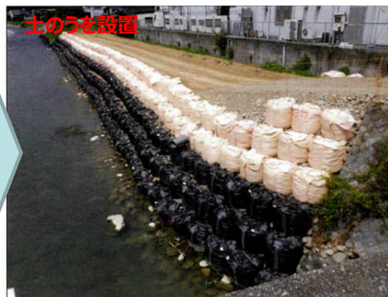
崩れた堤防斜面への応急対応の様子 (関賀地区) 揖保川左岸44.2k付近
