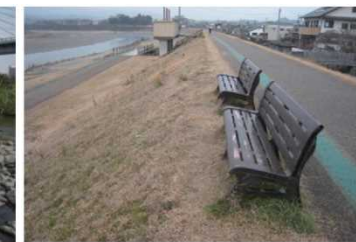
ベンチの設置
