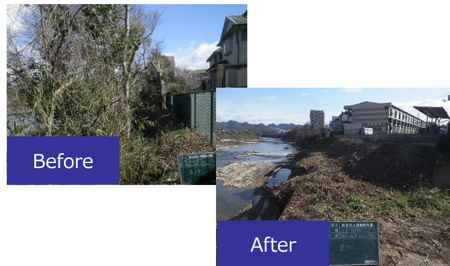
加古川右岸33.5k付近
