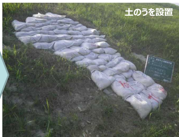
崩れた堤防斜面への応急対応の様子 加古川右岸27.0k付近
