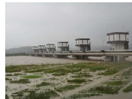
▲ゲート操作中の加古川大堰（H30.7）
