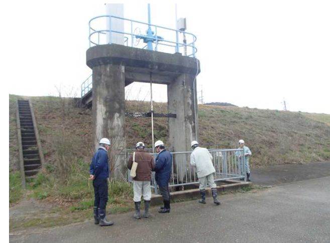
▲ 許可工作物の点検の様子
