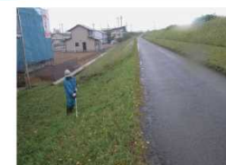
堤防上の草刈り
