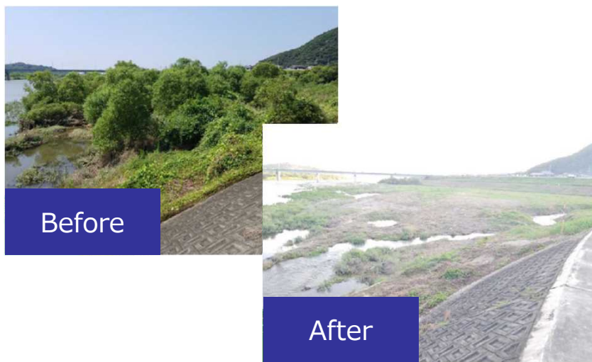
加古川右岸9.6k付近
