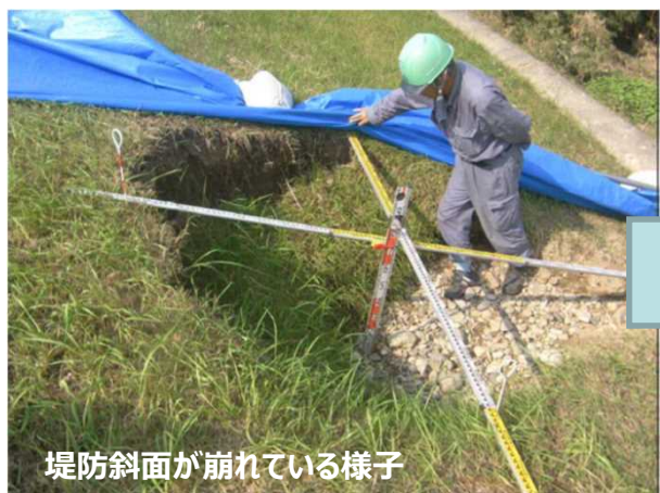
崩れた堤防斜面への応急対応の様子 加古川右岸27.0k付近
