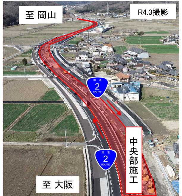
上り車線(神戸方面)の交通が北側の走行車線に切り替わり、中央部にて工事を行っています。
