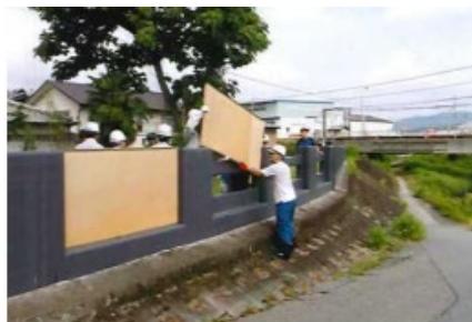
畳堤へ畳を設置している状況
