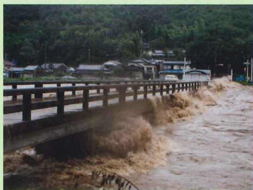
兵庫県宍粟市山崎町 旧神河橋付近
