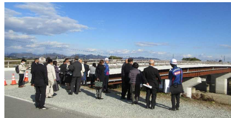
大門地区：築堤・橋梁架け替えなどの工事説明
