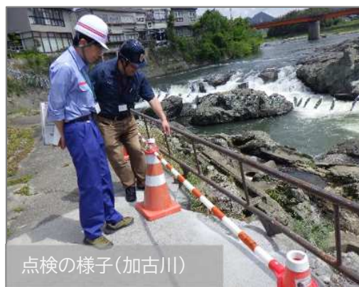
点検の様子(揖保川)
