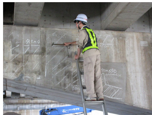
▲打音点検の状況（魚橋第二高架橋）
