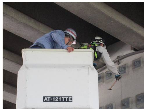
▲目視と高所作業車により点検を実施しました（玉手高架橋）
