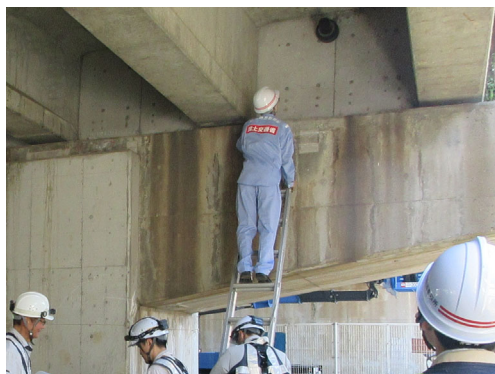
▲高所作業車が入らない箇所のため、脚立により確認しました（魚橋第二高架橋）
