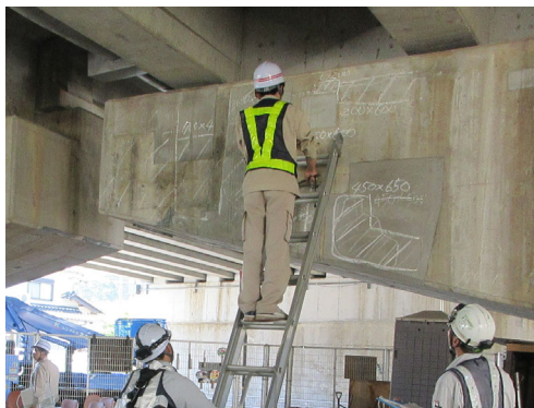
▲高所作業車が入らない箇所のため、脚立により確認しました（魚橋第二高架橋）
