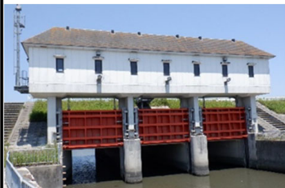
揖保川 蟠洞川排水樋門 (余部出張所)
