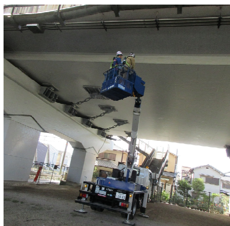
▲高所作業車に乗って損傷状況を確認（亀山3号高架橋）
