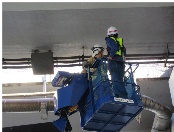
▲高所作業車に乗って損傷状況を確認（亀山3号高架橋）
