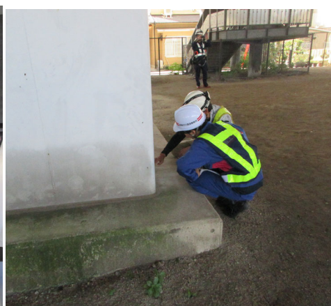
▲橋脚部の確認（亀山3号高架橋）
