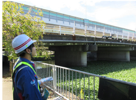
←ドローンの操作 点検状況確認 （三佐衛門堀側道橋）
