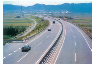
暫定供用した第一期区間 (姫路市北原付近)
