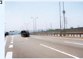
6車化が完了 (姫路東ランプ付近)
