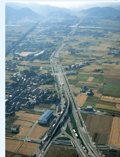
全線4車線供用 (太子竜野バイパス終点付近)
