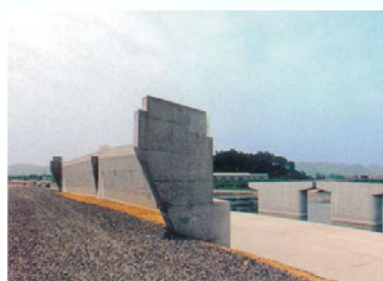
工事中の林田大橋
