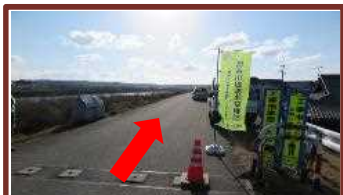
車両入口付近
