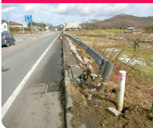
ガードレール・標識等の損傷
