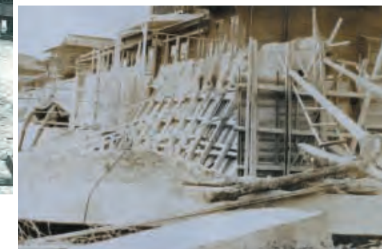
復旧工事状況（神戸市垂水区平磯地先）
