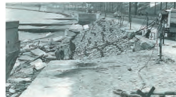
復旧工事状況（神戸市垂水区舞子地先）
