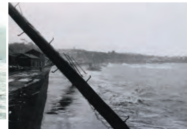
昭和39年20号台風で倒壊した電柱（神戸市垂水区狩口地先）
