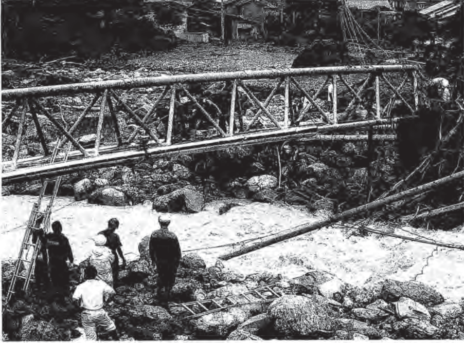
自衛隊員らに助けられ、水管橋を渡って避難する住民。すぐ下の福知川は濁流が逆巻いている＝10日午後5時半ごろ、宍粟市一宮町福知（提供写真）
