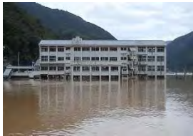
H26. 8 避難所2階の浸水(徳島県)
