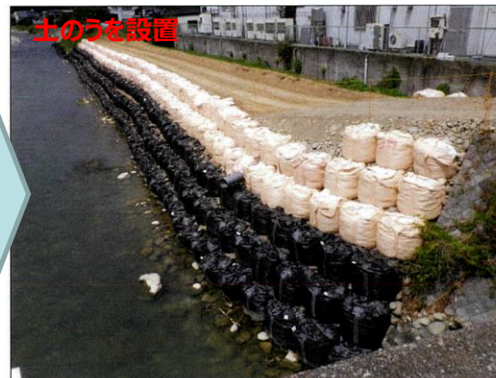
▲崩れた堤防斜面への応急対応の様子（平成30年7月の例） （関賀地区）揖保川左岸44.2k付近
