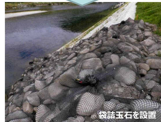
▲崩れた護岸への応急対応の様子 （平成30年7月の例）
