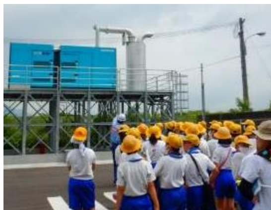
屋外発電機の見学
