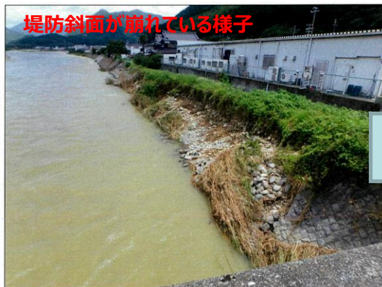
▲崩れた堤防斜面への応急対応の様子（平成30年7月の例） （関賀地区）揖保川左岸44.2k付近
