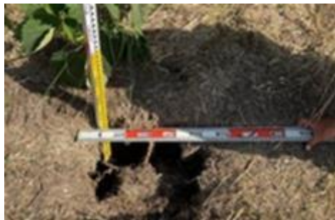
加古川の河川敷で発生した陥没の様子
