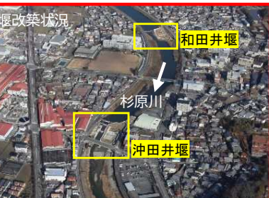
<堰改築事例(杉原川)>兵庫県
