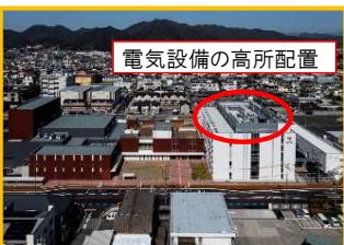
電気設備の高所配置(西脇市)
