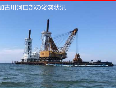
<河道掘削事例(加古川河口部)>姫路河川国道事務所
